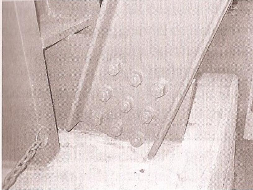
Conexión de un diagonal de canal al alma de una columna. Observe la placa de unión soldada al alma de la columna y el atiesador del alma, así como los canales dobles utilizados como contraventeo atornillados a la placa.
